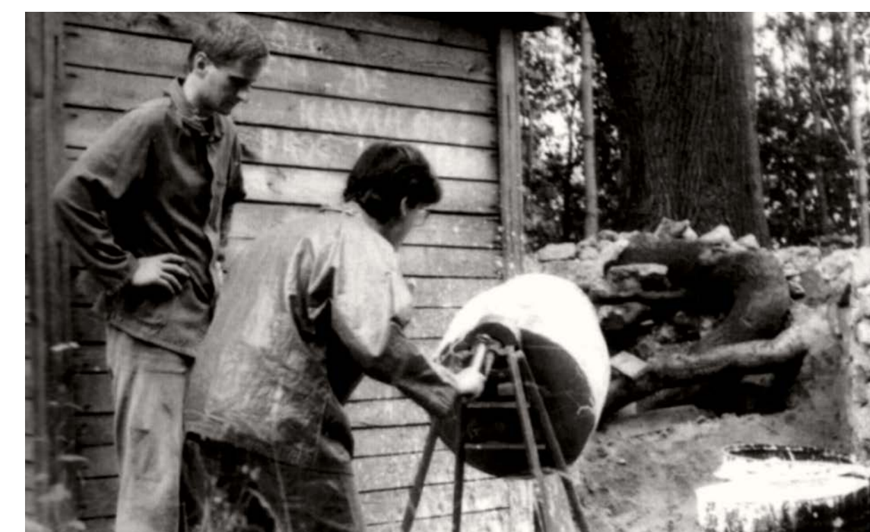
Malta ke spárování se míchala v ruční míchačce.
